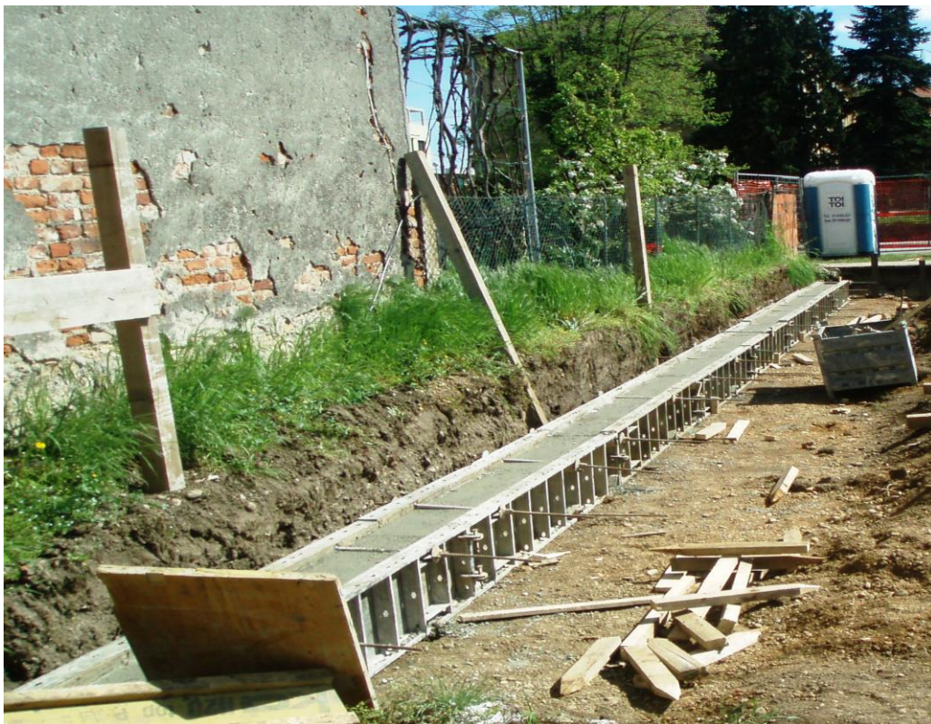
Slika 31. Zabijanje čeličnih IPE profila
