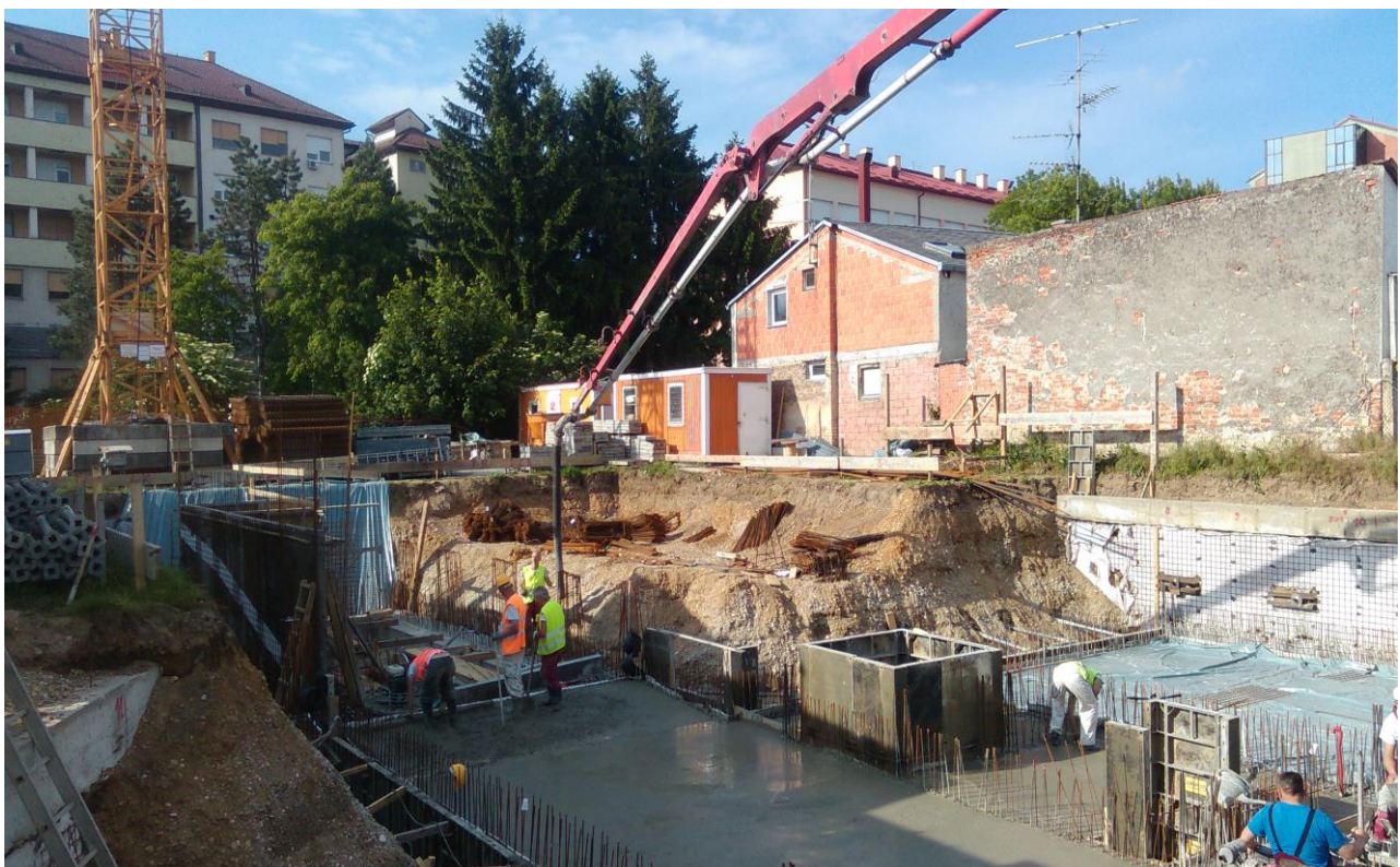
Slika 2. Građevna jama na predmetnoj lokaciji
