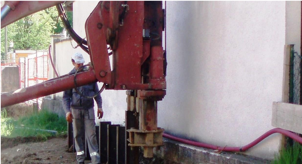
Slika 31. Zabijanje čeličnih IPE profila
