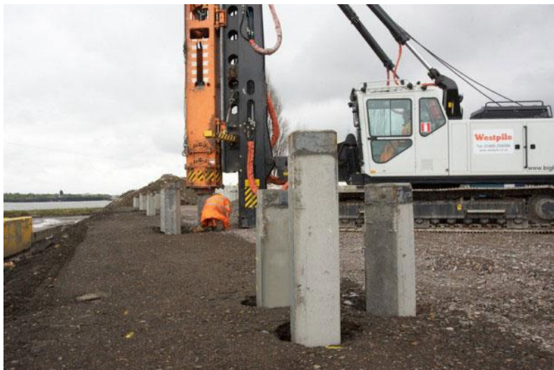
Slika 10. Betonsko žmurje
