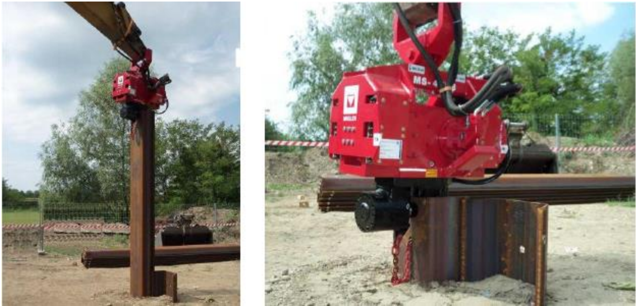
Slika 7. Vibrator za nabijanje i vađenje talpi
