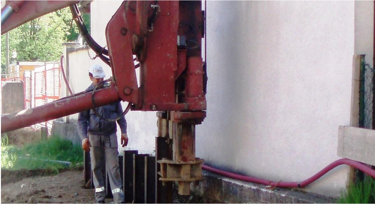
Slika 31. Zabijanje čeličnih IPE profila
