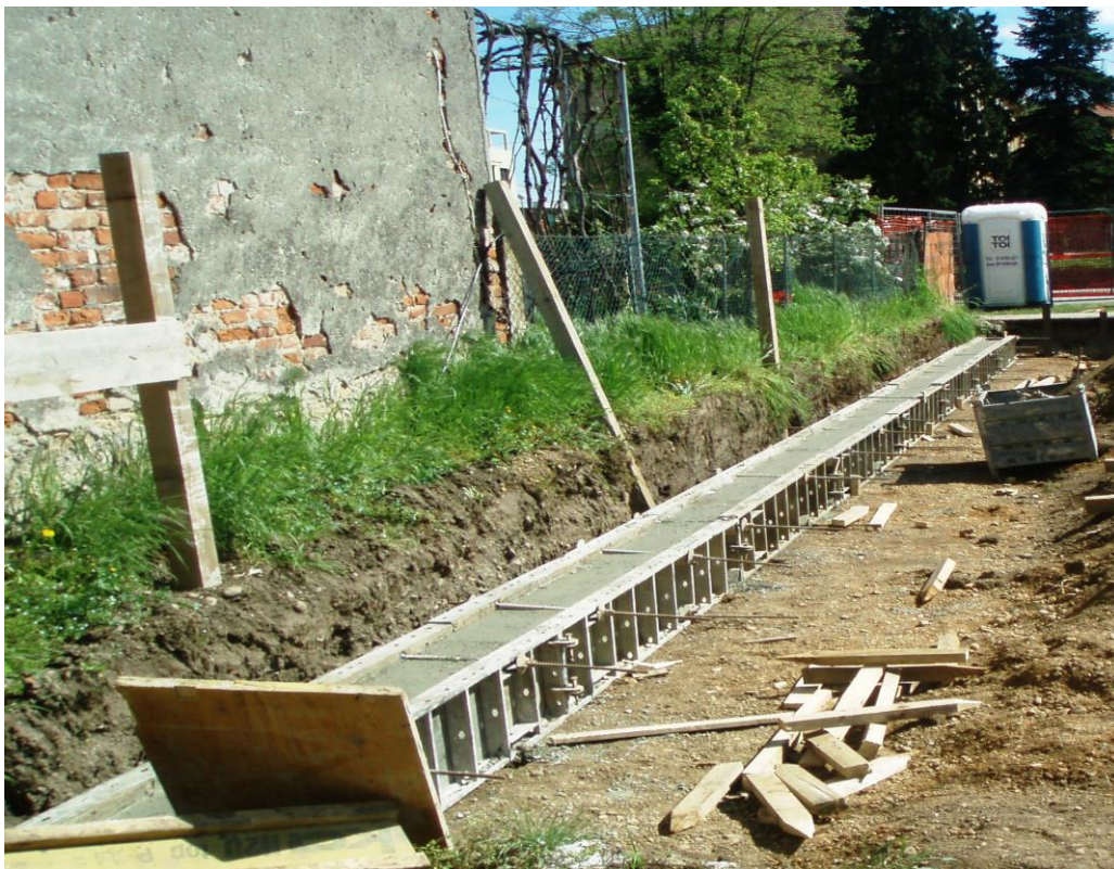
Slika 31. Zabijanje čeličnih IPE profila
