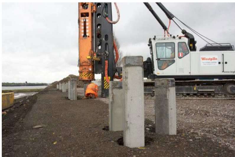
Slika 10. Betonsko žmurje
