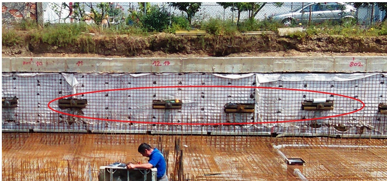
Slika 49. Izvedene glave geotehničkih sidara
