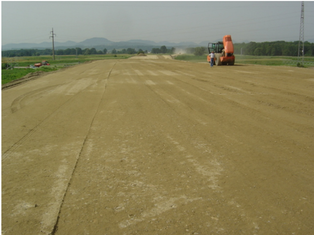
Slika 17. Uređeni sloj nasipa od prirodnog šjunka, Varaždin 2006 g.
