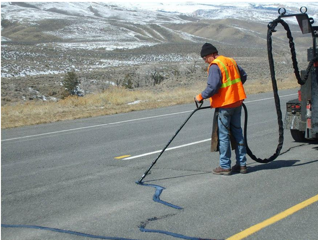
Slika Error! No text of specified style in document..3 Krpanje pukotina [4]
