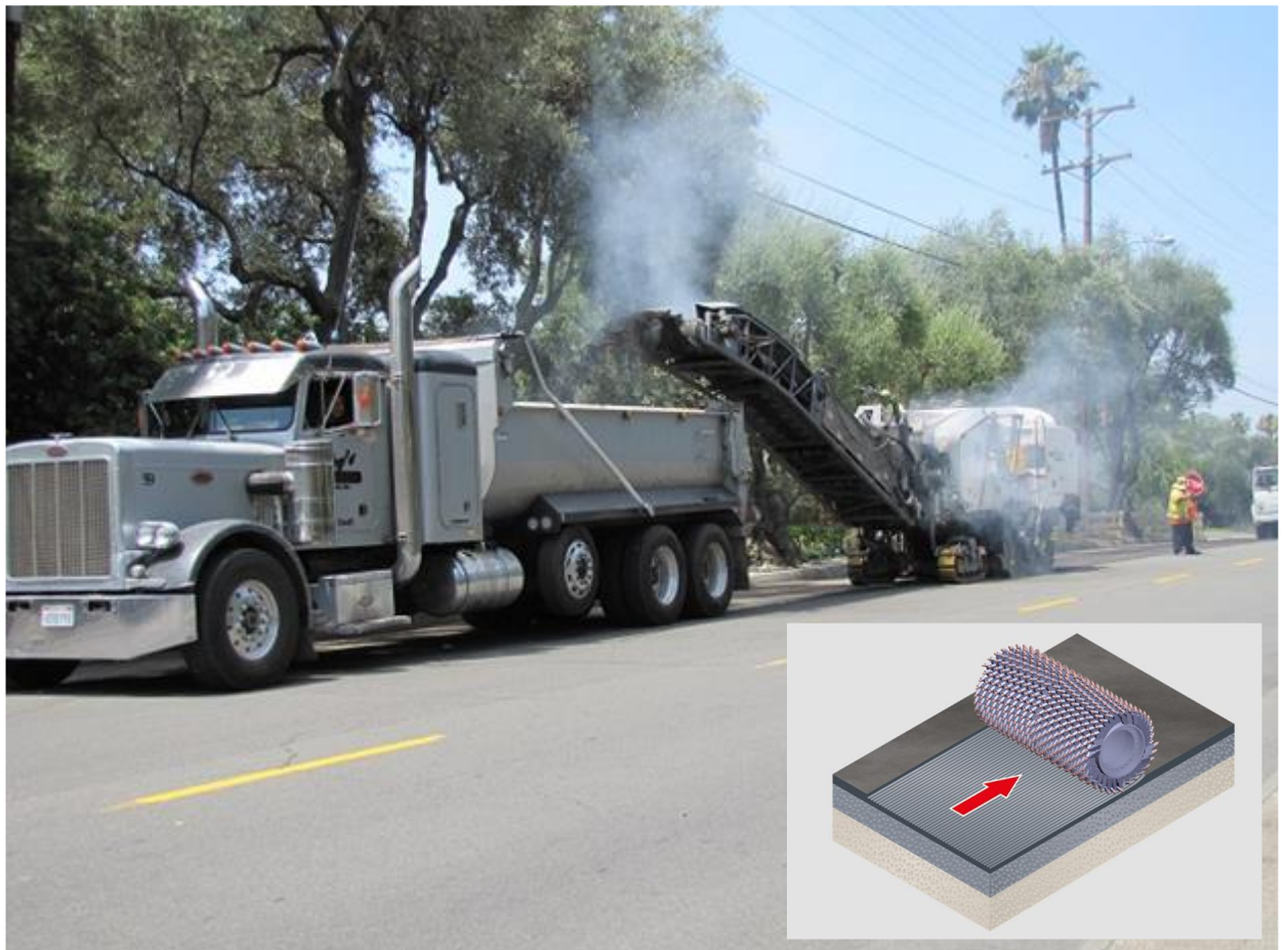
Slika Error! No text of specified style in document..5 Mikro frezanje [6]
