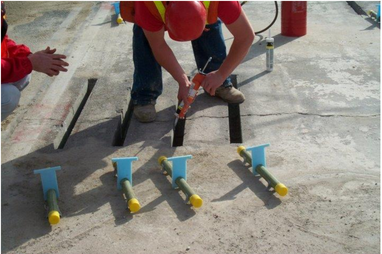
Slika Error! No text of specified style in document..8 Rezanje utora za postavljanje spojnih šipki
