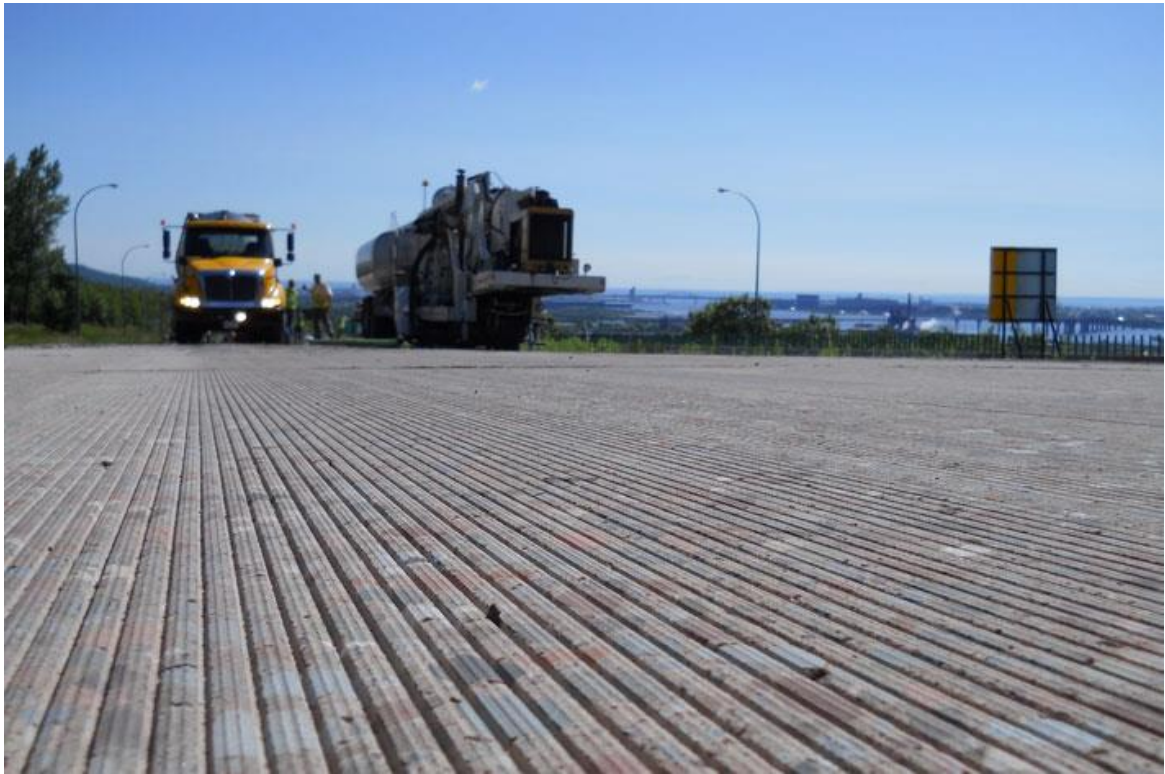
Slika Error! No text of specified style in document. 6 Površinsko dijamant brušenje [7]
