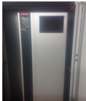
Slika 2.4 Frekventni pretvarač
