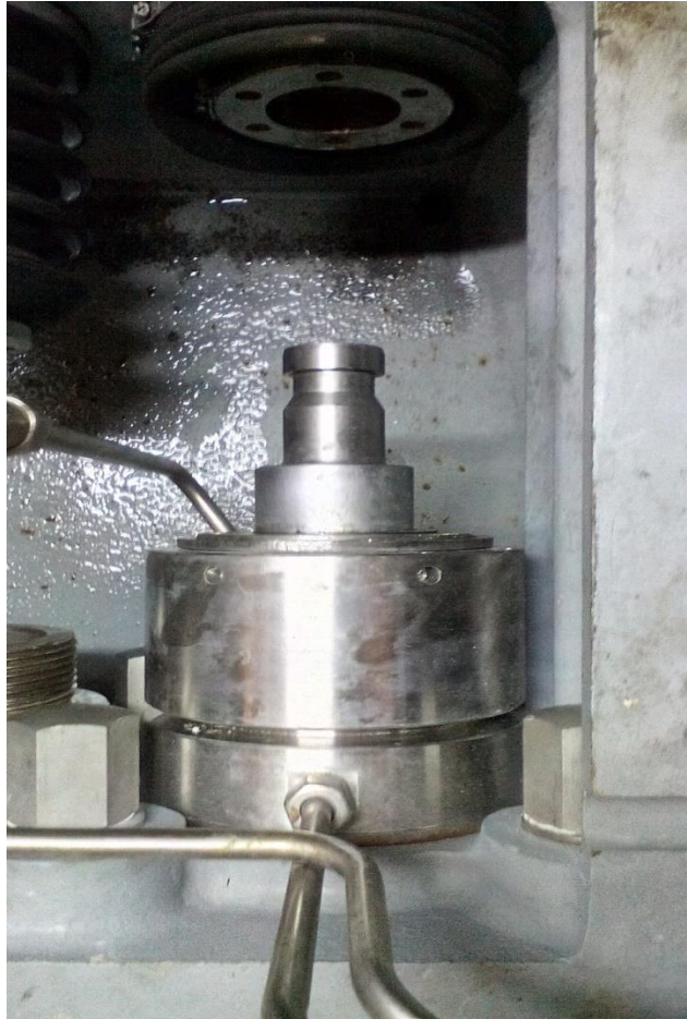
Slika 5.3 Položaj klipa prije demontaže
