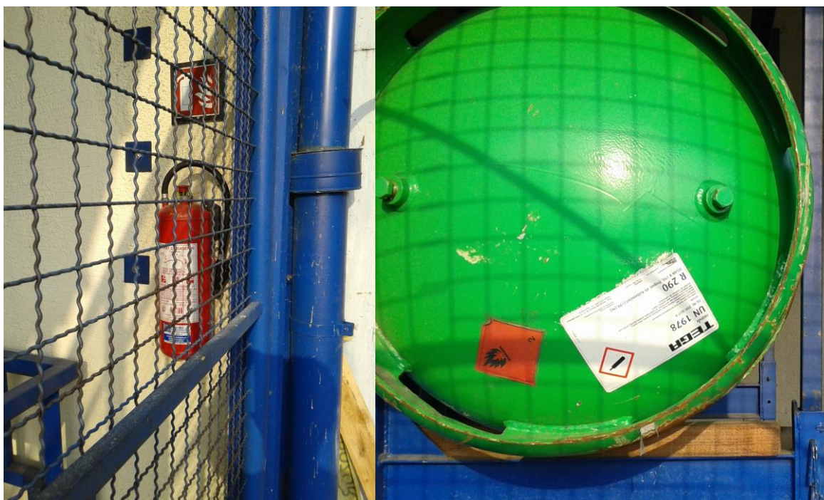
Slika 19. Aparat za gašenje požara i spremnik propana
