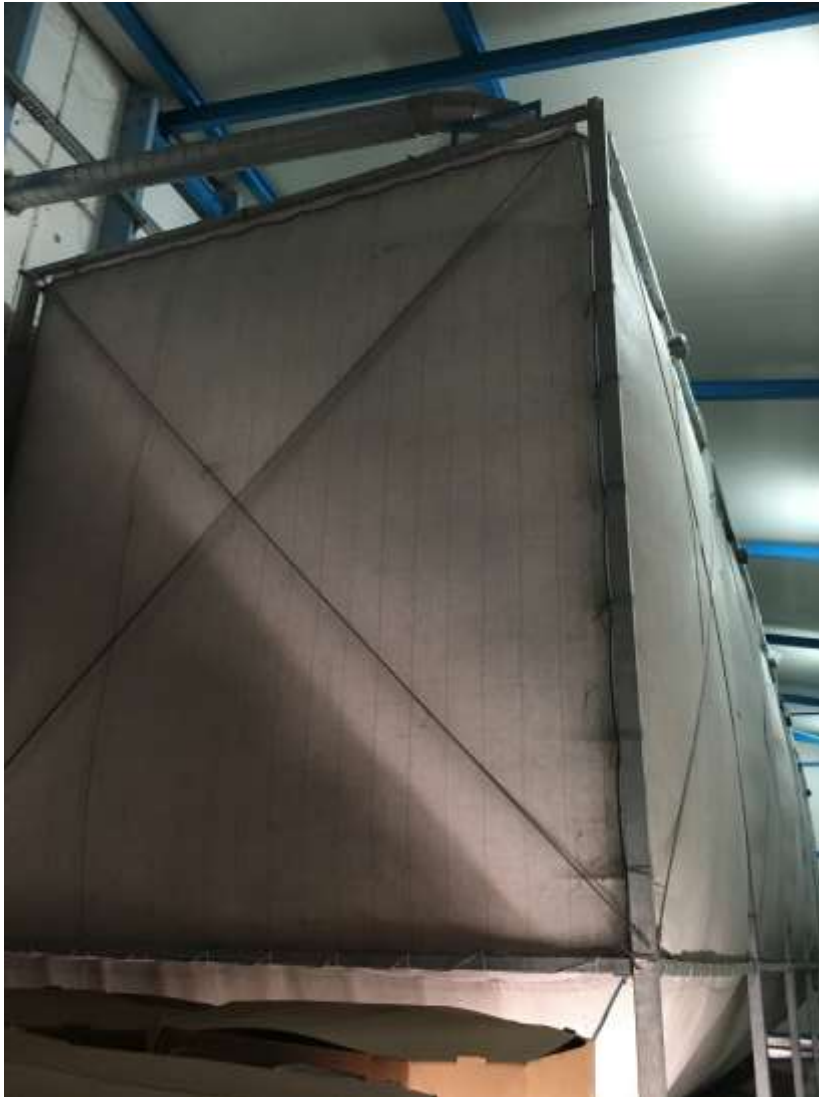
Slika 4.10 Silos za čuvanje ekspanziranih granula polistirena
