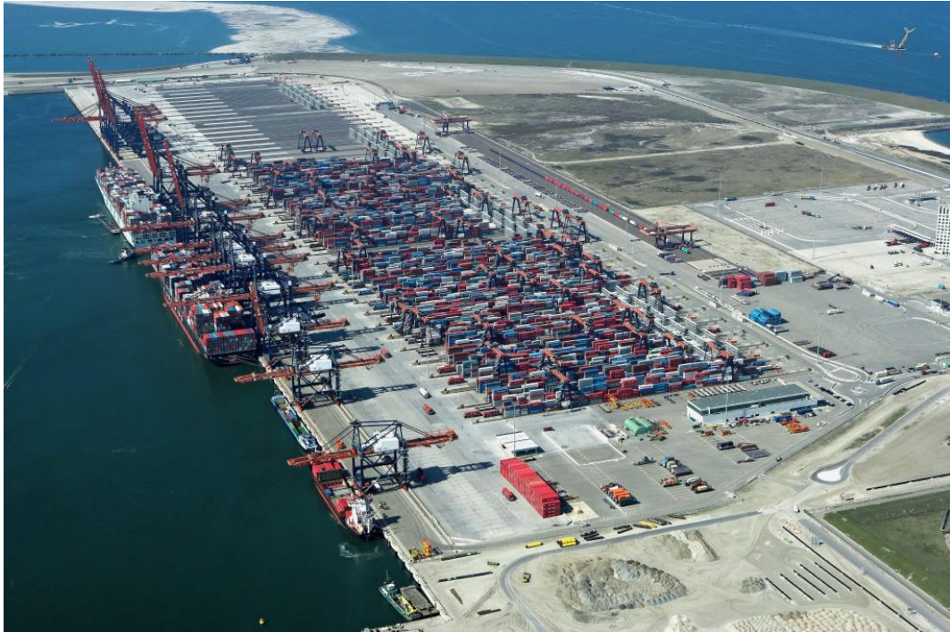
Slika 3.3.:Otvoreno skladište kontejnera u luci Rotterdam, Nizozemska [20]
