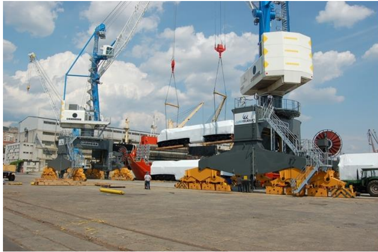
Slika 6.2.:Kontejnerska dizalica marke Liebherr [30]
