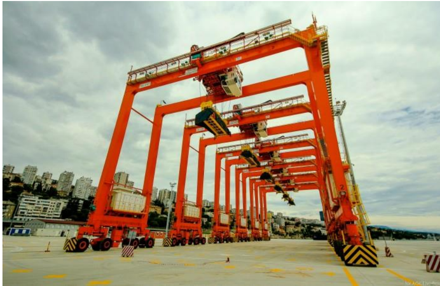
Slika 6.8.:RTG dizalice marke ZPMC [30]
