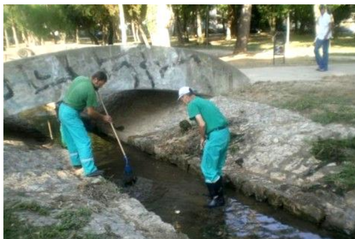
Slika 7.2 Primjeri mehaničkog održavanja otvorenih kanala
