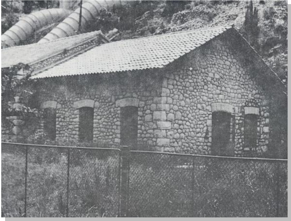
Slika 5.8 Crpna stanica "Jaruga I" s dogradnjom
