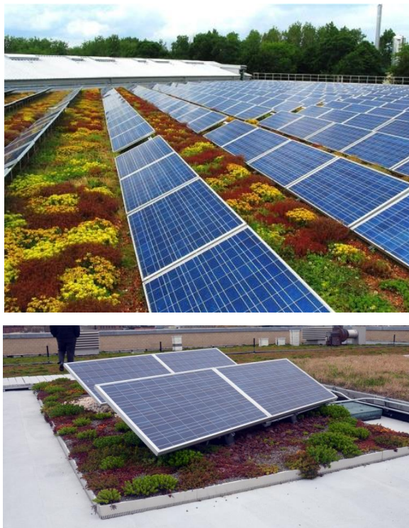
Slika 9.4.2.1. Fotonaponske ćelije na zelenom krovu
