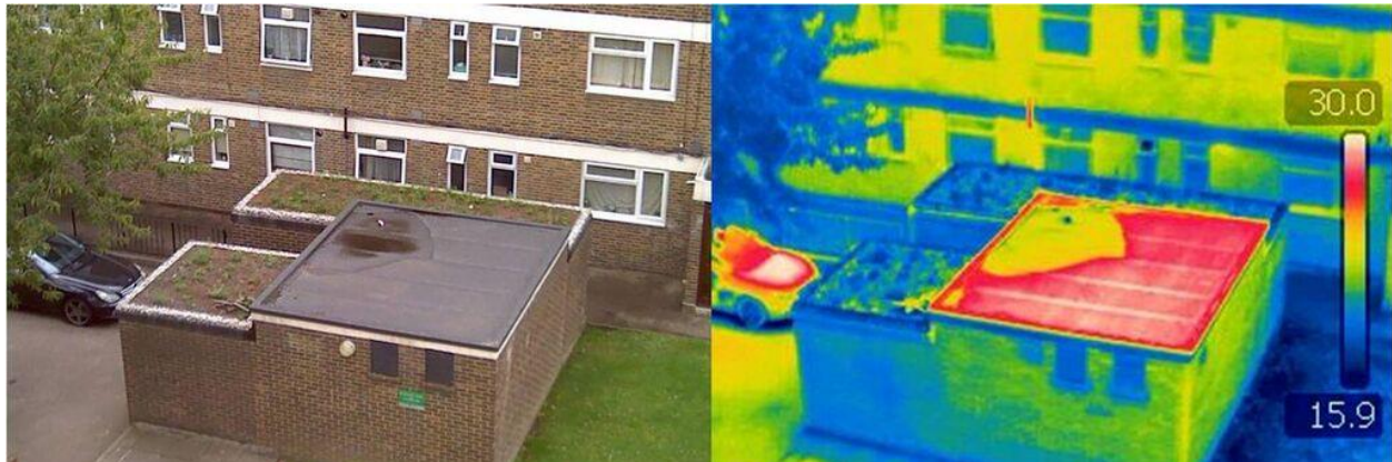
Slika 9.1.1.2. Temperaturna razlika zelenog i običnog ravnog krova vidljiva na termalnoj snimci (desno)
