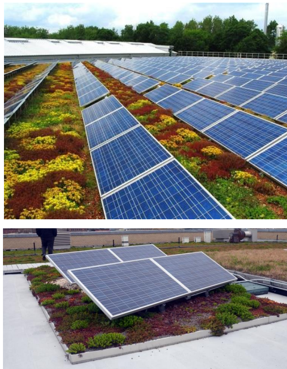
Slika 9.4.2.1. Fotonaponske ćelije na zelenom krovu
