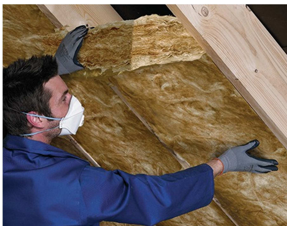
Slika 2.20 Kosi krov izoliran mineralnom vunom
