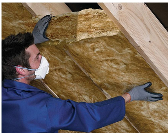
Slika 2.20 Kosi krov izoliran mineralnom vunom
