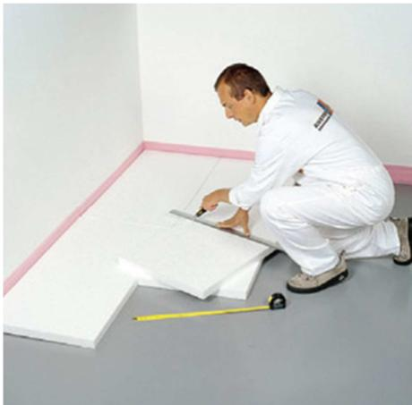
Slika 2.18 Pod izoliran EPS pločama
