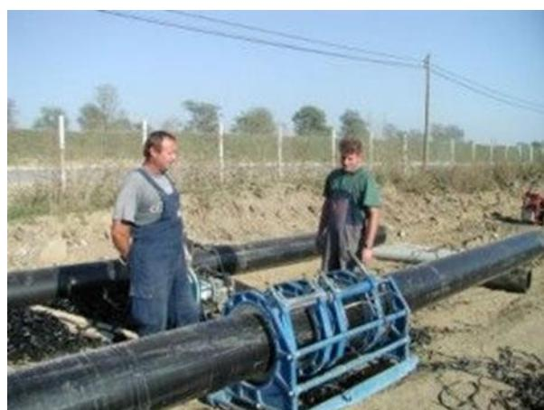
*Slika 2.5 Radovi na izvedbi sustava odvodnje procjednih voda (<http://his.hr>, 2016.)*
