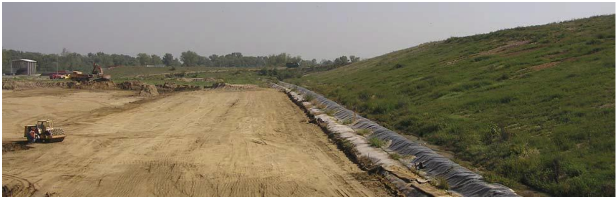
Slika 2.2 Postavljanje temeljnog brtvenog sustava na odlagalištu Jakuševac ( http://www.mzoip.hr/doc/tehnicko-tehnolosko_rjesenje_55.pdf , 2016.)
