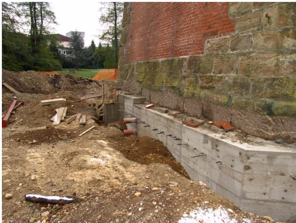
Slika 3.15. Sanacija peterokutnog bastiona
