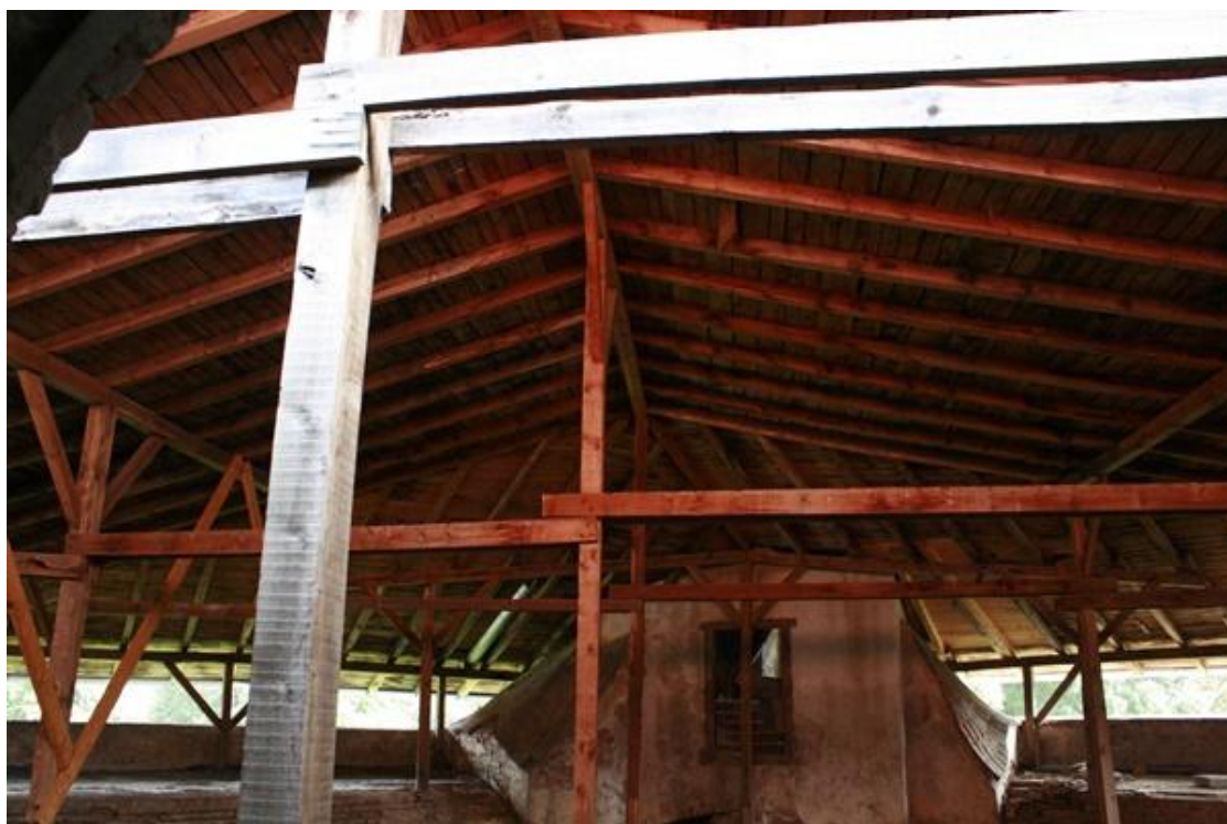
Slika 4.8. Privremena drvena nadstrešnica
