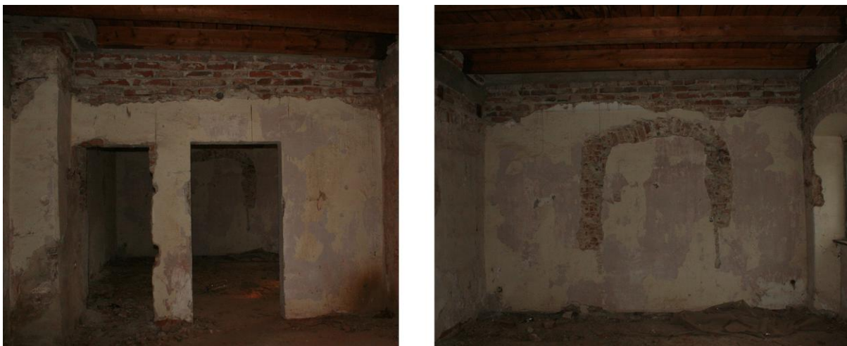
Slika 4.1. Prikaz dva postojeća zida
