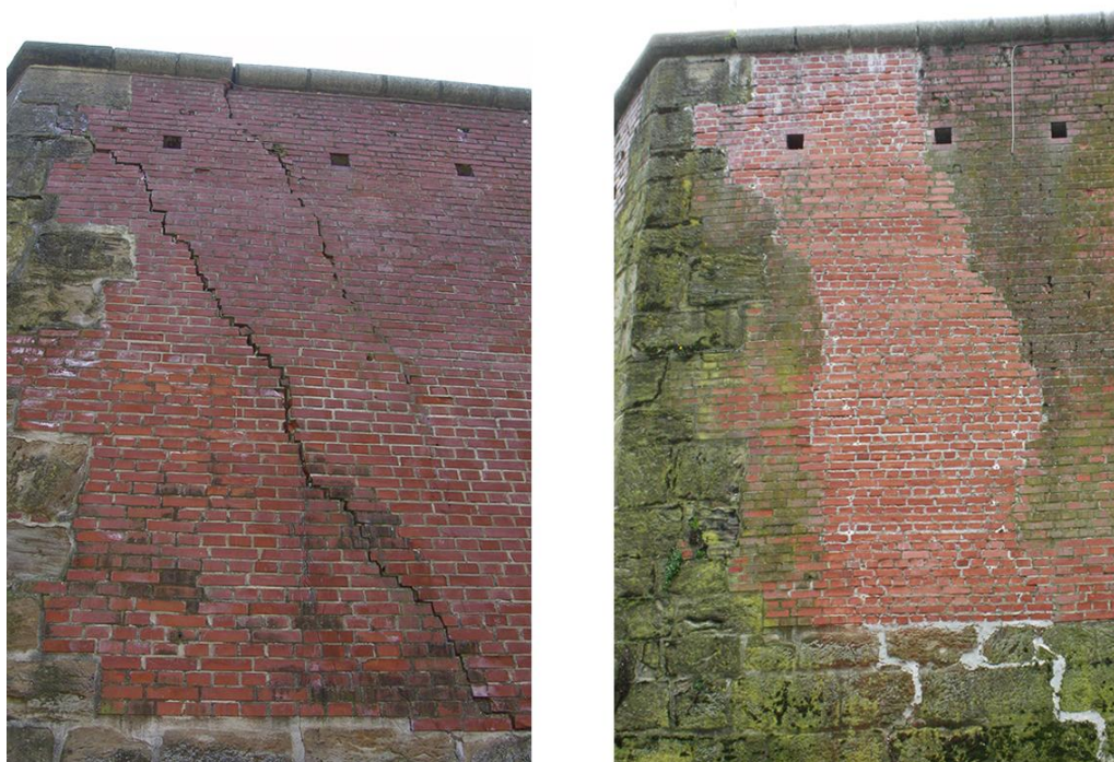
Slika 4.21. Sanacija zida bastiona, 2006. godine
