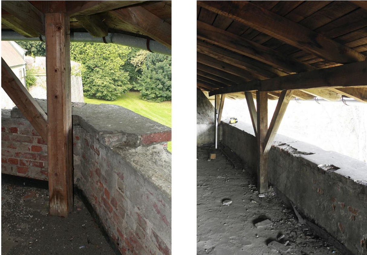
Slika 4.11. Postojeće stanje grudobrana
