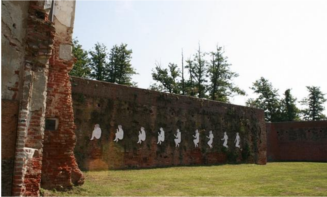
Slika 3.13. Zid utvrde - kurtina
