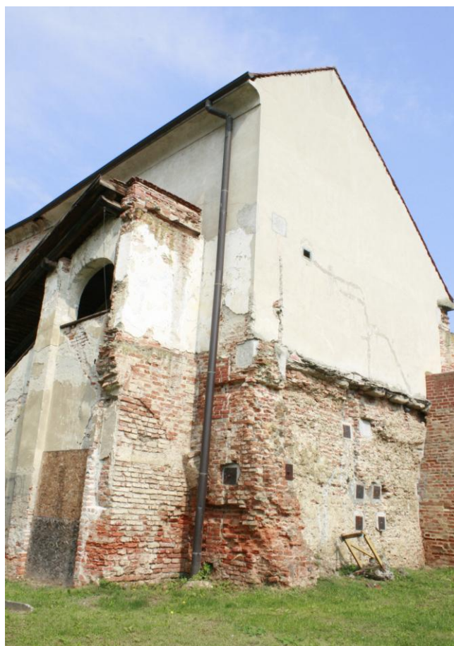
Slika 4.18. Krajnji zid "radiostanice"
