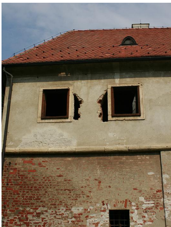
Slika 4.5. Pukotine u zidovima I. i II. dilatacije
