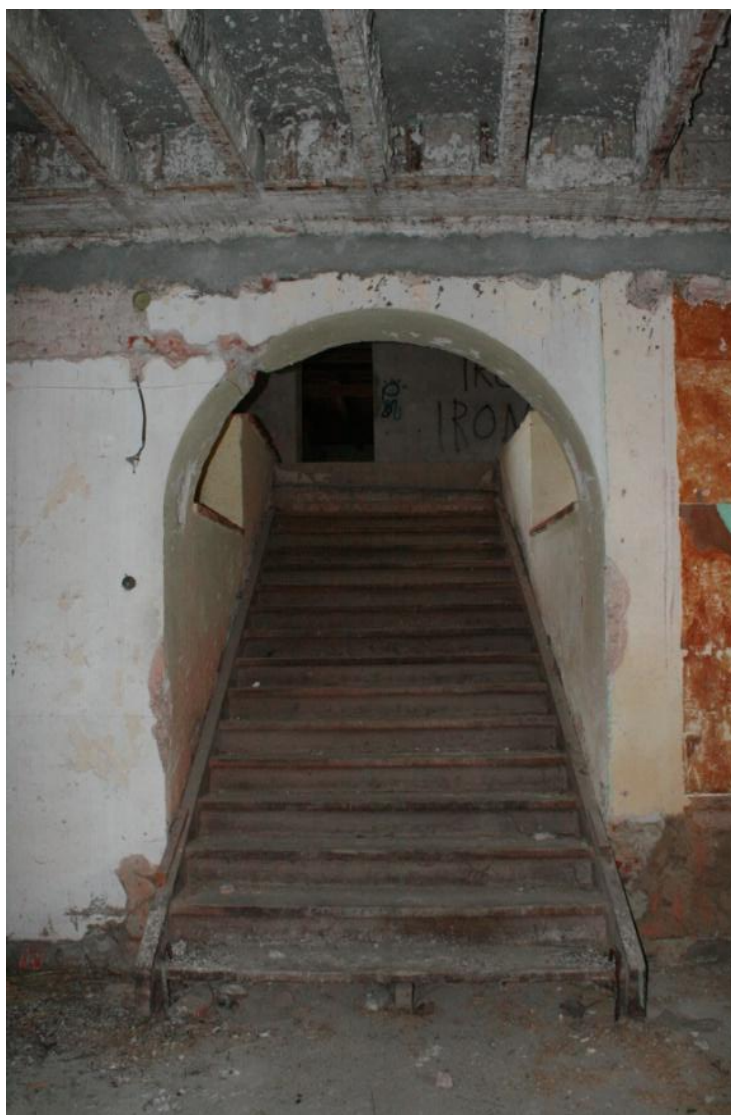
Slika 4.19. Postojeće drveno stubište
