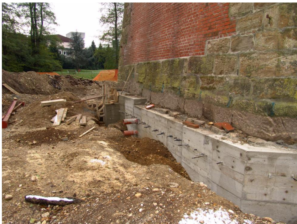
Slika 3.15. Sanacija peterokutnog bastiona
