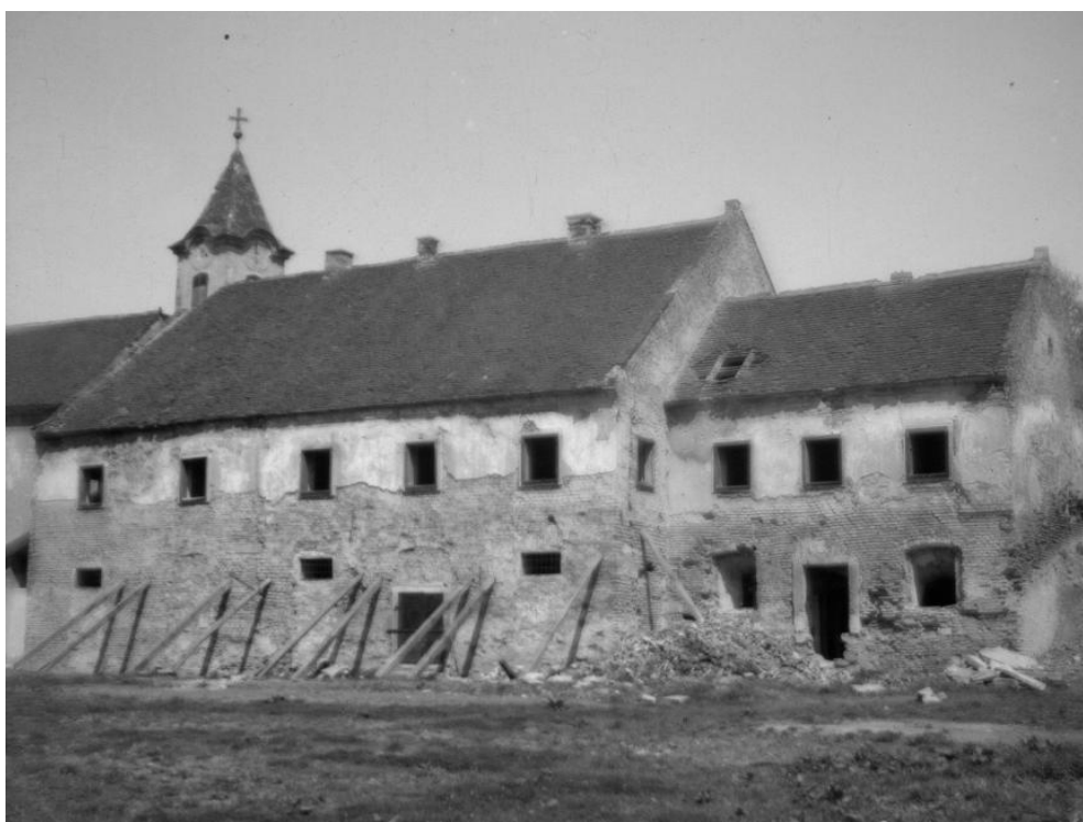
Slika 3.12. Srušena građevina iz 18.st.
