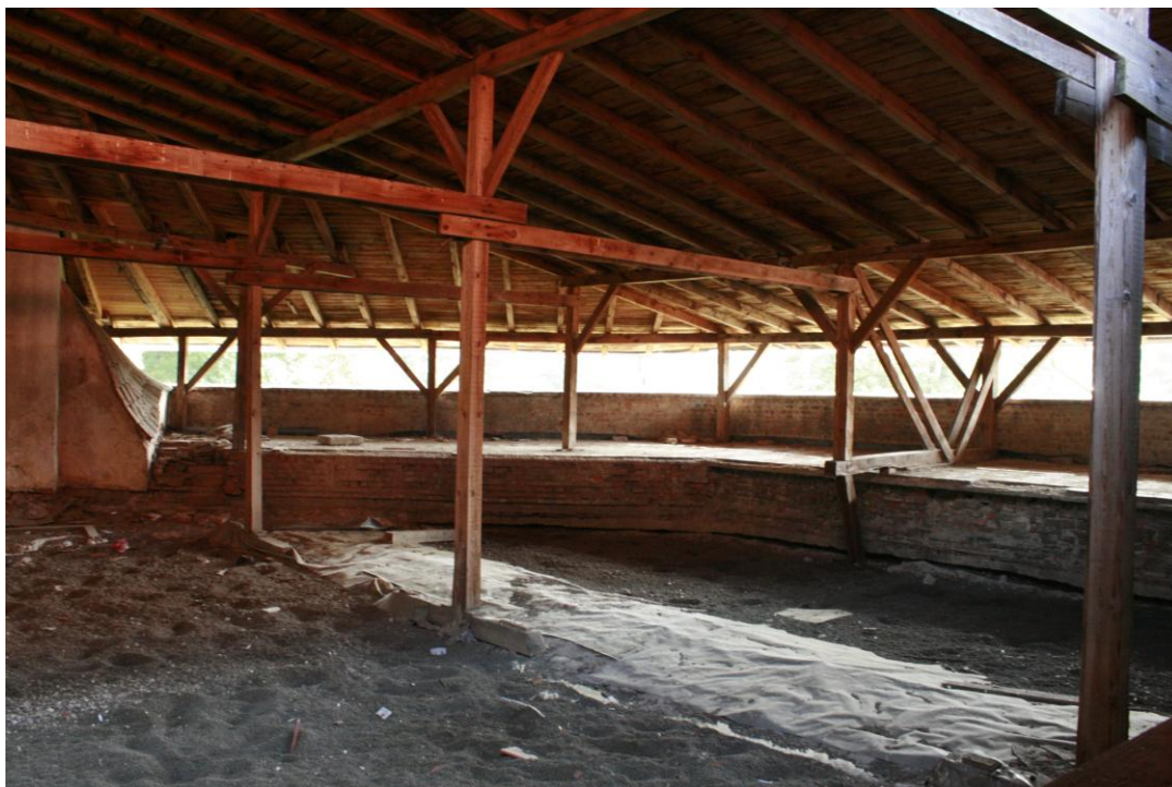
Slika 3.9. Natkrivena terasa ulaznog bastiona
