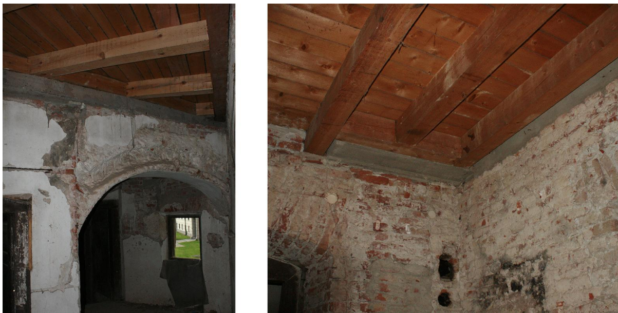
Slika 3.6. Ojačanje postojećih zidova I. kata
