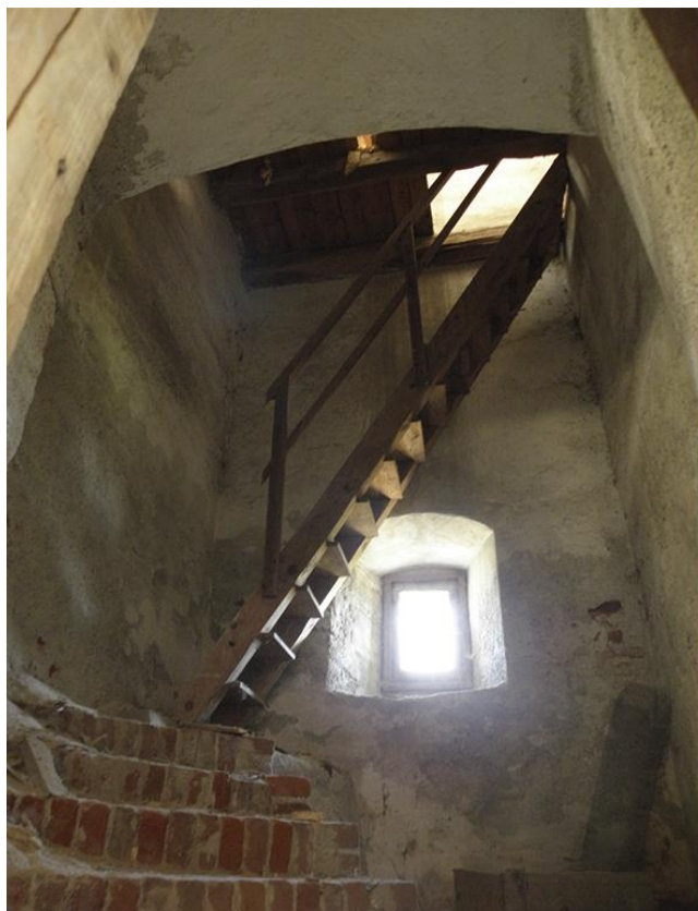
Slika 4.6. Postojeće drveno stubište
