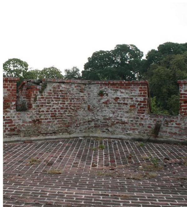
Slika 4.4. Oštećenje grudobrana SZ bastiona
