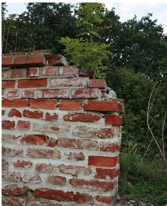
Slika 4.4. Oštećenje grudobrana SZ bastiona
