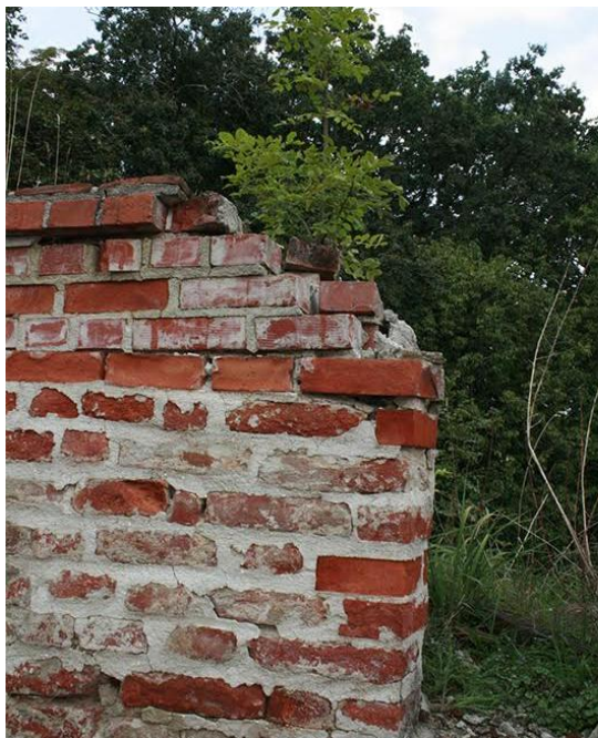
Slika 4.4. Oštećenje grudobrana SZ bastiona
