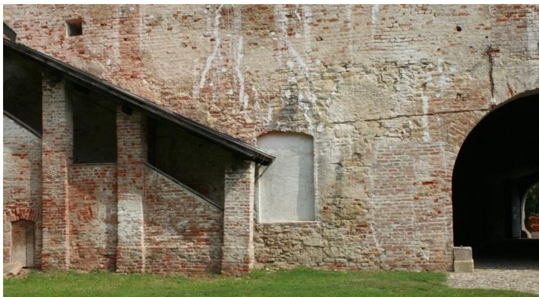
Slika 4.16. Zazidani otvora prozora u prizemlju
