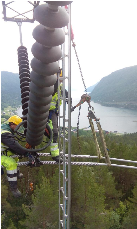
Slika 4.15. Pričvršćivanje faznih vodiča na nosivom stupu
