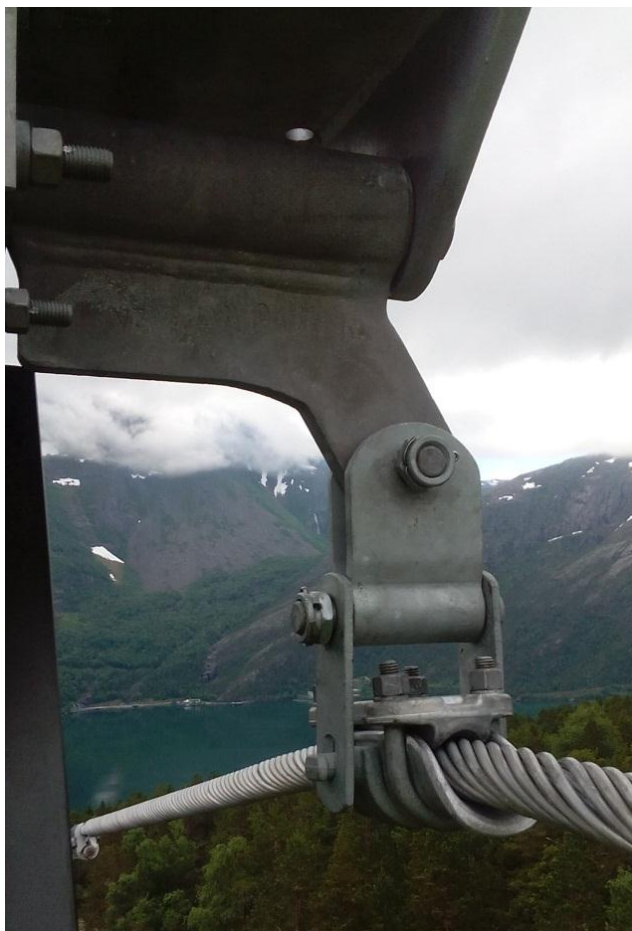
Slika 4.18. Pričvršćivanje zaštitnog vodiča
