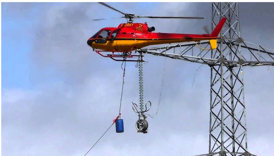
Slika 4.3. Razvlačenje užeta za vanjske faze
