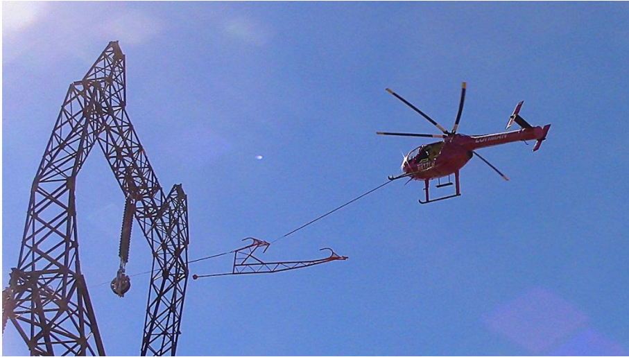
Slika 4.4. Razvlačenje užeta za srednju fazu
