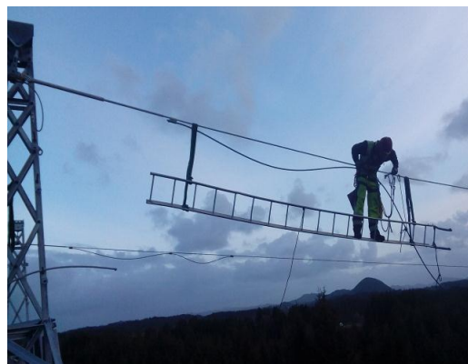
Slika 4.20. Postavljanje "dempera"
