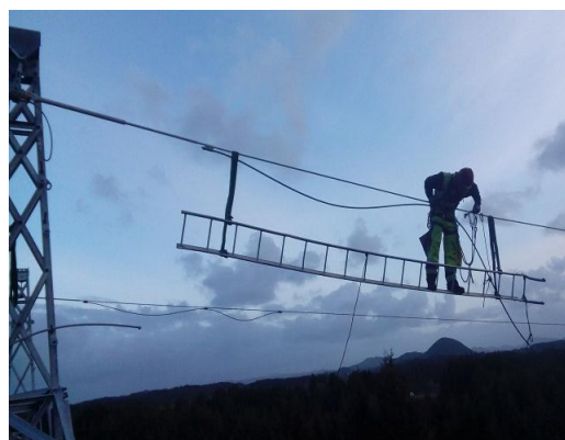
Slika 4.20. Postavljanje "dempera"
