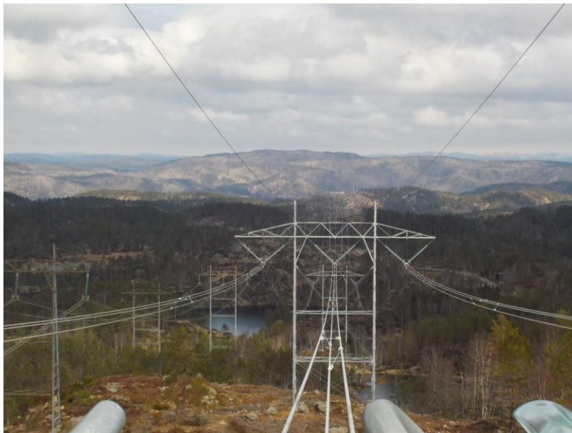
Slika 4.24. Postavljeni međufazni odstojnici
