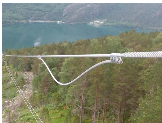
Slika 4.19. Postavljeni "demper"
