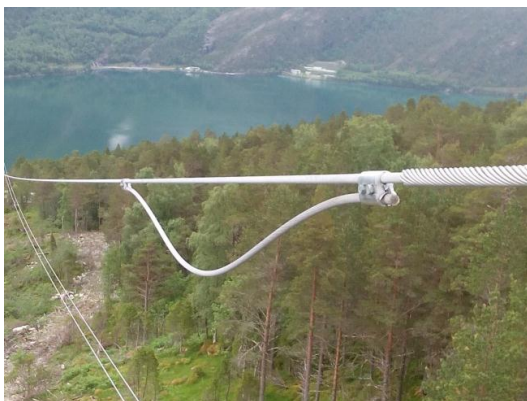
Slika 4.19. Postavljeni "demper"
