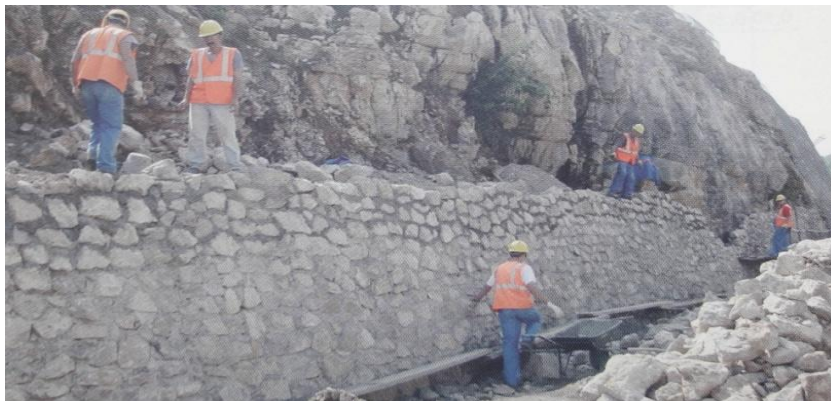
Slika 4.22: Izrada obložnog zida od lomljenog kamena u cementnom mortu
