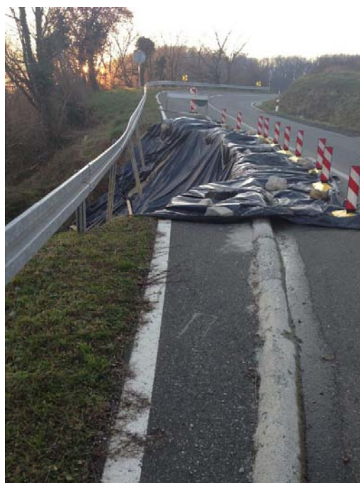
Slika 8.6: Preventivne mjere za uspostavljanje stabilnosti – ublažavanje klizanja izvedene su 2013. godine, odvodnjom vode izgradnjom kanalica uz zasjek, sprečavanjem udara vode na čelo klizišta i pokrivanjem nepropusnom folijom za oborine na klizni segment
