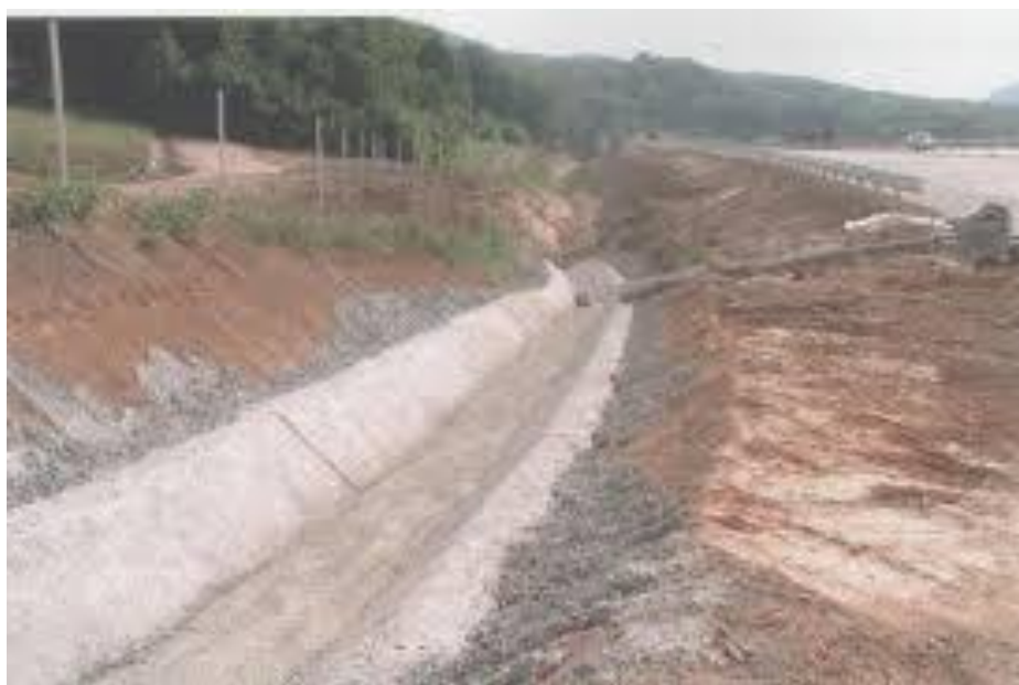
Slika 3.4: Trapezni odvodni jarak (Dragčević, Rukavina 2006.)
