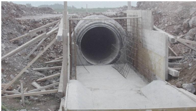
Slika 3.40: Poprečni presjek cijevnog propusta
