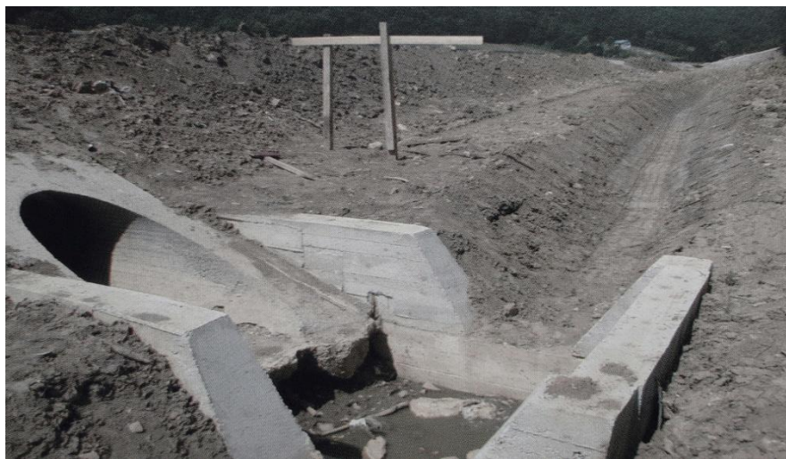
Slika 5.45: Uljevna glava propusta
