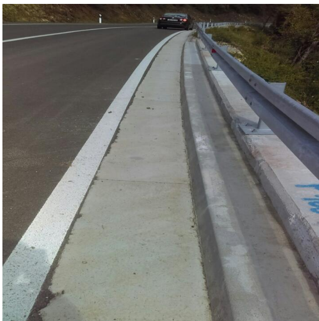
Slika 8.30: Sustav odvodnje površinskih voda (rigol s rubnjakom)
