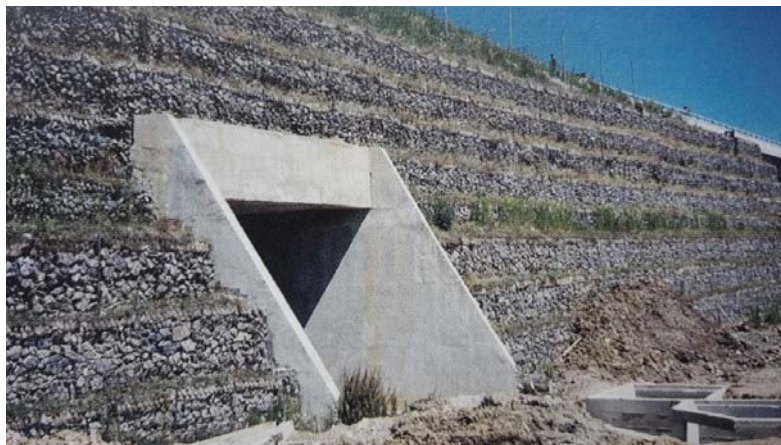
Slika 3.49: Izljevne glave propusta
