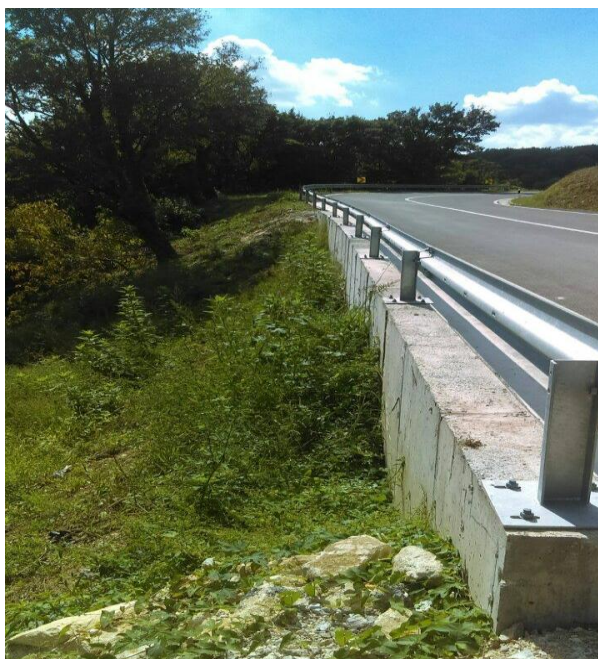
Slika 8.31: Izvedeno stanje potpornog zida
