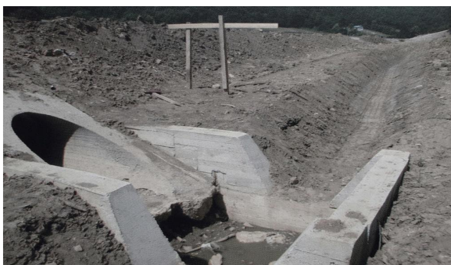
Slika 5.45: Uljevna glava propusta
