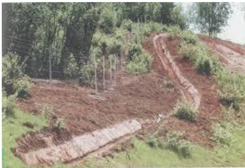
Slika 3.9: Zaštitni jarak na padini iznad usjeka
