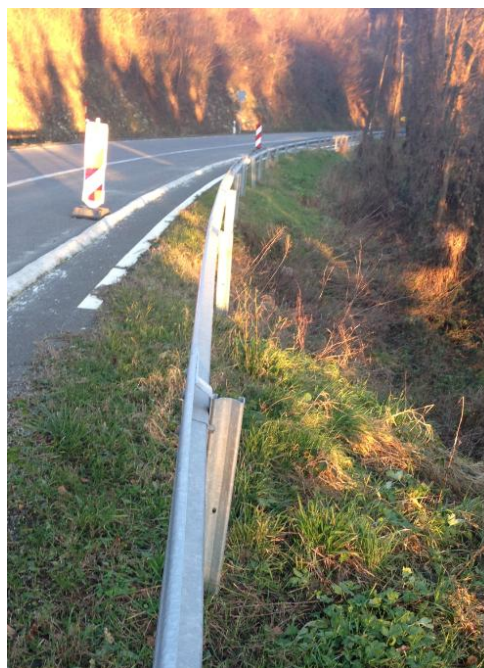
Slika 8.5: Na bližem potezu ceste vidljivo je više puzišta (sporo klizanja) na bankini i cesti
