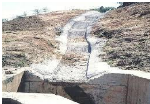
Slika 3.7: Kaskadno izeveden jarak
