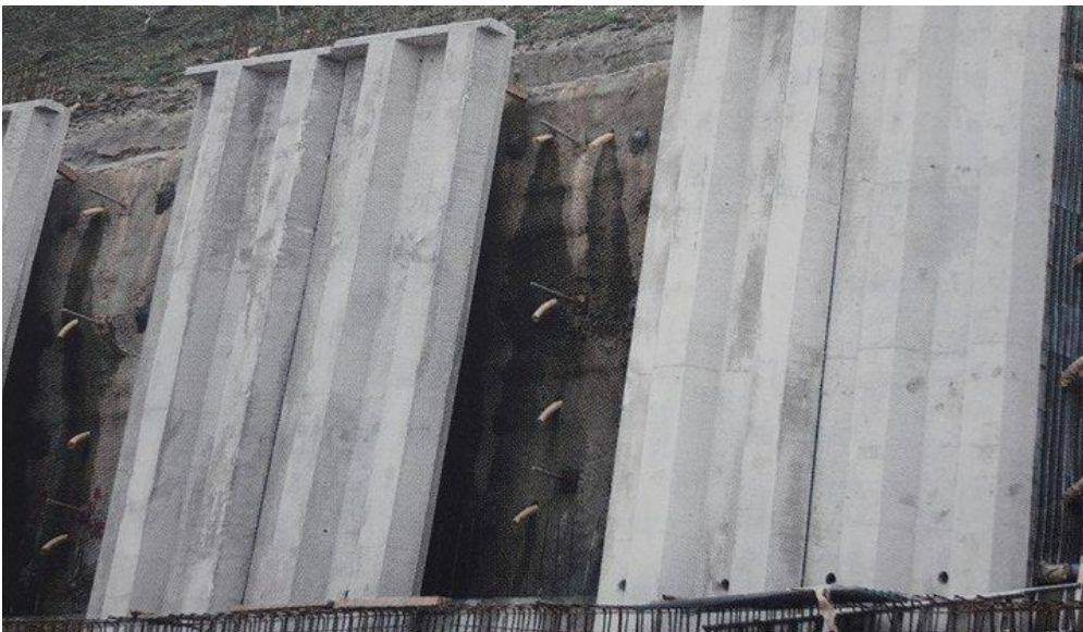
Slika 4.13: Izrada zida u kampadama ( Dragčević, Rukavina 2006. )
