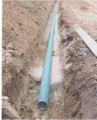
Slika 3.21: Plastična drenažna cijev na podlozi od betona
