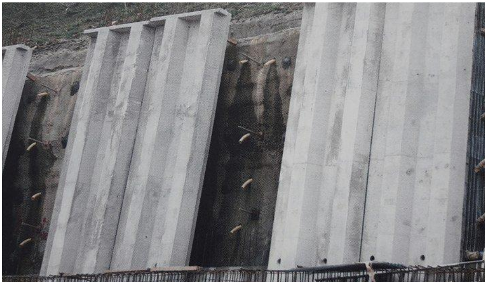
Slika 4.13: Izrada zida u kampadama ( Dragčević, Rukavina 2006. )
