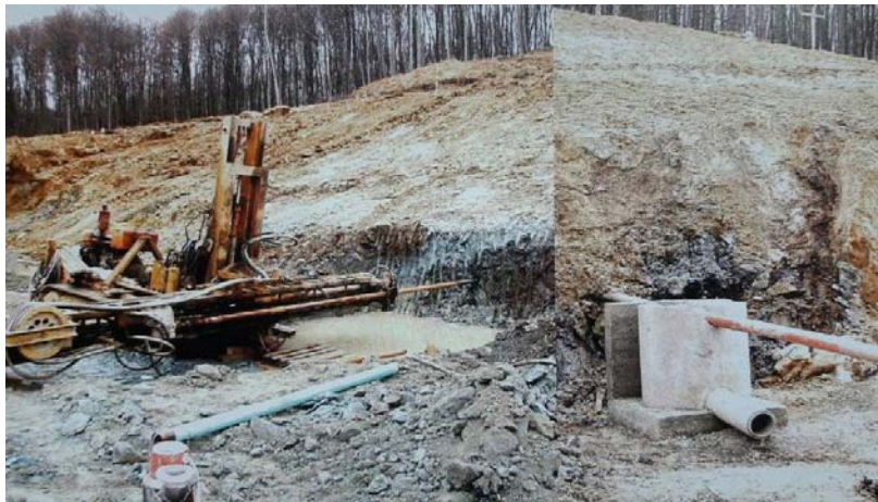
Slika 3.33: Bušenje horizontalne drenaže s detaljem spoja na vanjsku odvodnju
