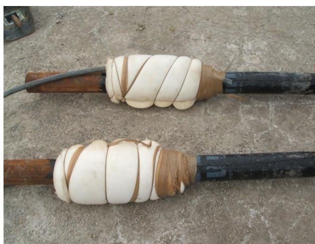
Slika 8.28: Brtva sa spojem čelične i okiten cijevi
