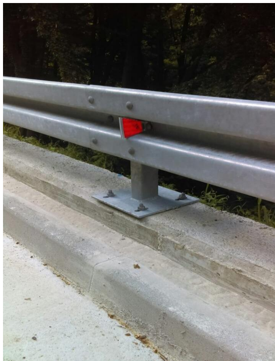
Slika 8.33: Detalj zaštitne ograde - H2 iz priloga P15-1
