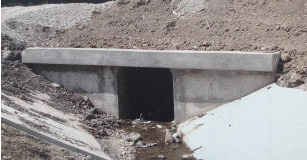
Slika 3.42: Pločasti propust
