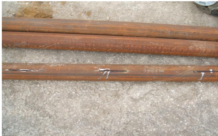
Slika 8.27: Perforiranje čelične cijevi 1,0 m od vrha cijevi
