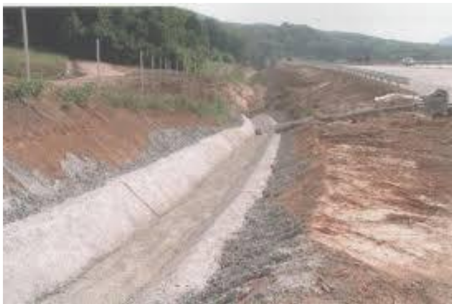
Slika 3.4: Trapezni odvodni jarak (Dragčević, Rukavina 2006.)
