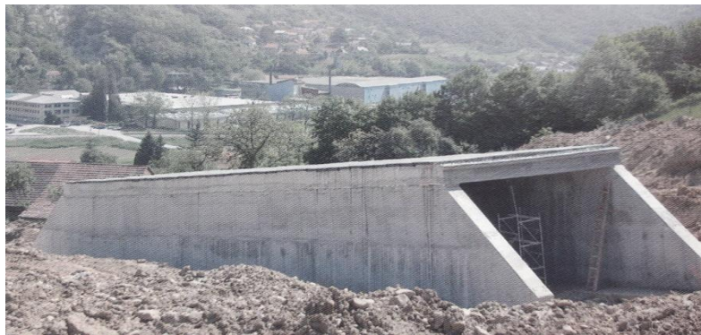
Slika 3.4: Gradnja pločastog propusta
