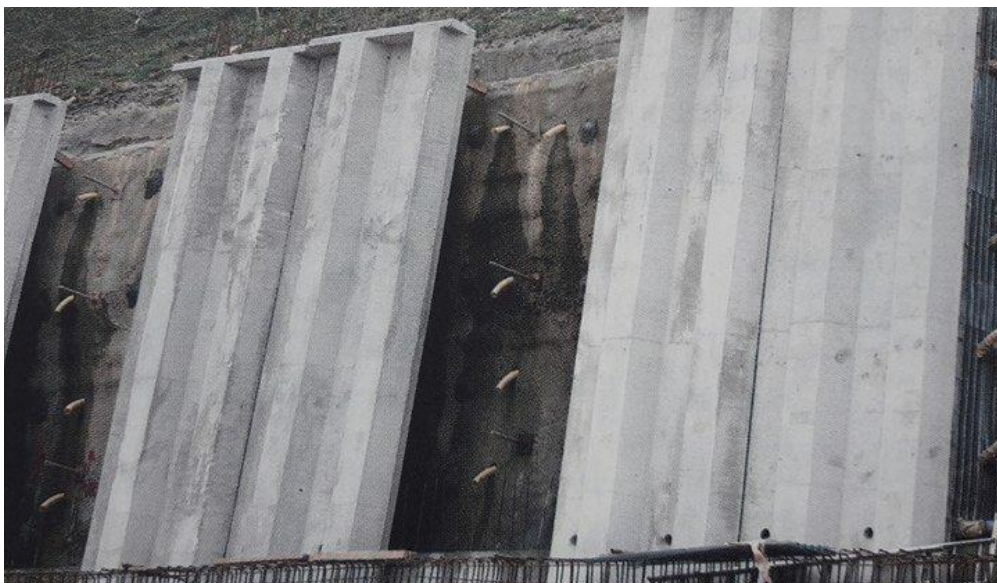
Slika 4.13: Izrada zida u kampadama ( Dragčević, Rukavina 2006. )
