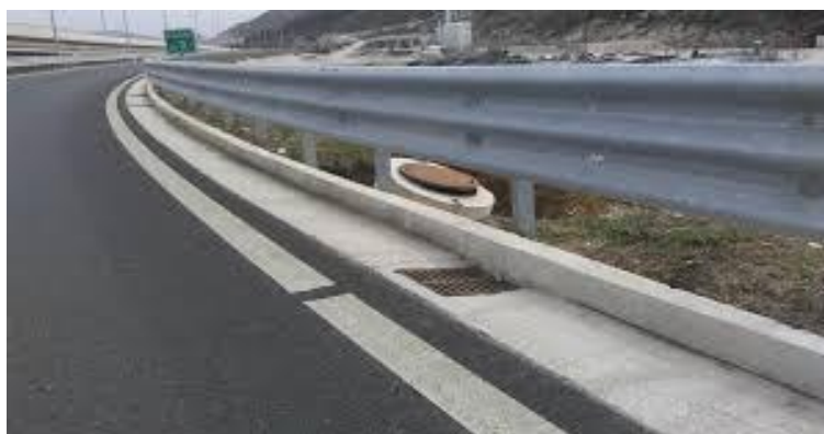
Slika 3.13: Betonski trokutasti rigol izveden kontinuirano
