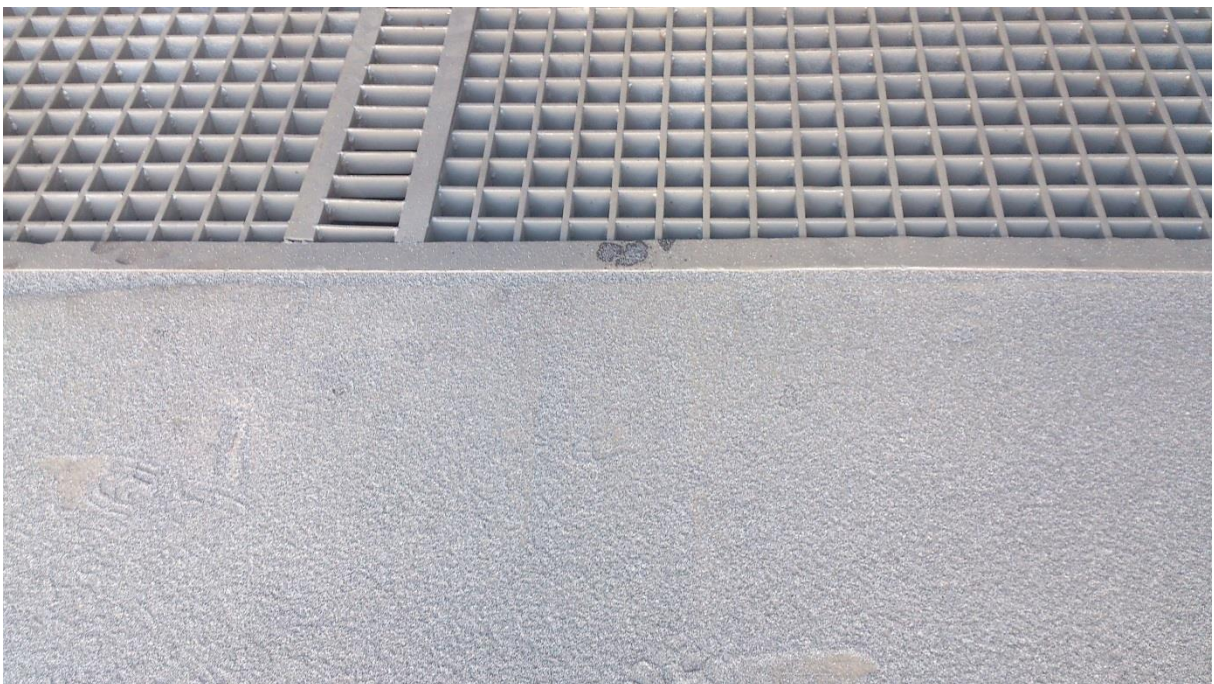
Slika 39 - Prostor za sakupljanje zrnaca te obradu za ponovno korištenje
