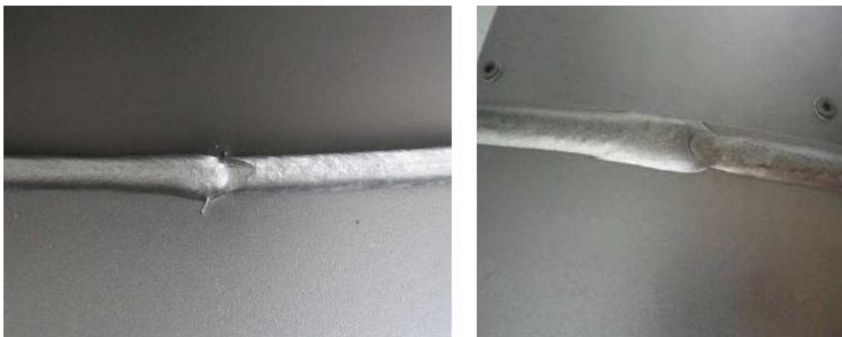
Slika 2.24 Nepravilno izveden nastavak zavara (517) [13]
